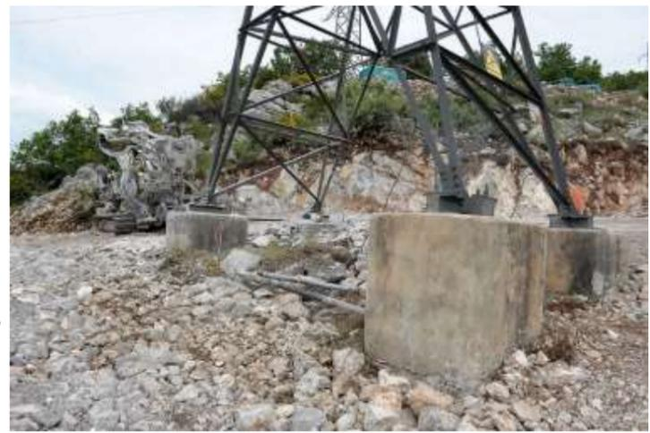
Sur la commune de Levens: remplacement des câbles conducteurs d'électricité et des paratonnerres de sept pylônes et 12 fondations de pylônes pour une meilleure solidité aux intempéries. En septembre, les pylônes seront installés avec l'aide d'un hélicoptère type « puma » pour une fin de travaux prévue fin 2016.
