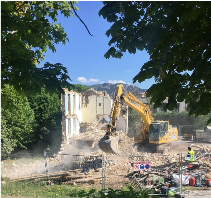
Démolition des deux maisons de la Colline: Planchers en partie écroulés, certains éléments extérieurs de façade et de toiture progressivement effondrés.
