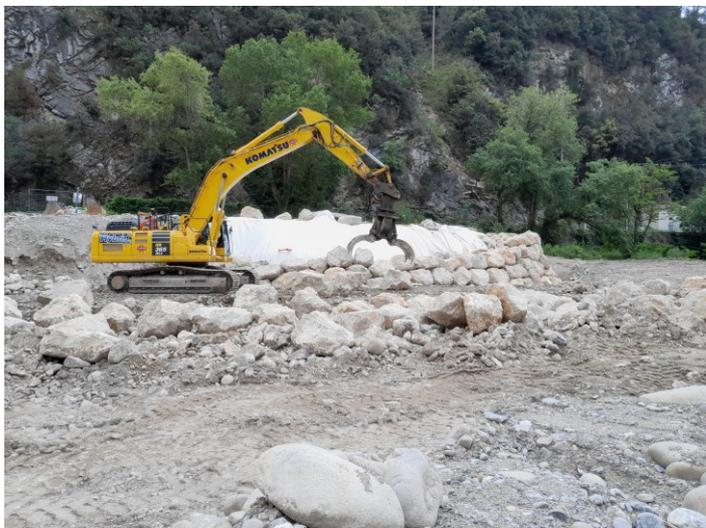
La crue générée par la tempête Alex a emporté une large partie de la berge et de l'enrochement existant au Plan du Var. Suite aux dégâts occasionnés, Eau d'Azur a réalisé des travaux de création d'un nouveau forage, de reconstitution de la protection des ouvrages vis-à-vis des crues de la Vésubie ainsi que l'abandon de l'ancien forage par comblement et démolition.
