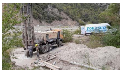
* Création d'un forage supplémentaire à Plan-du-Var
