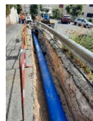
* Travaux de renforcement du réseau d'eau potable Avenue des Caroubiers à Villefranche-sur-Mer
