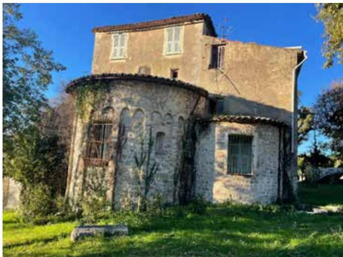
Les travaux de sécurisation de l'Abbaye de la Madone ont débuté en janvier. Après avoir dévégétalisé les façades, les échafaudages ont été montés pour procéder à la mise hors d'eau des absides, par la reprise des toitures ou la couverture provisoire en bac acier. Les travaux de confortement de l'absidiole sud, effondrée, sont quasiment achevés.
