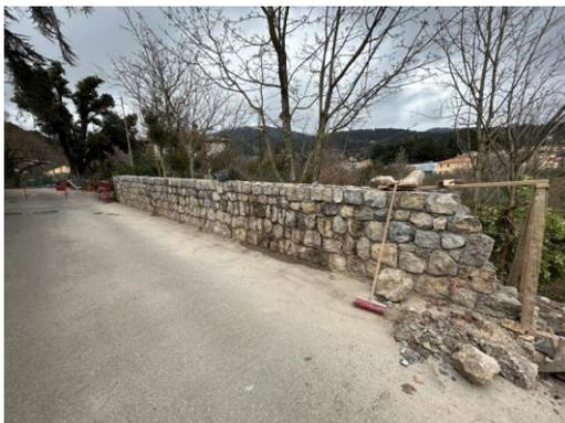
Travaux de reconstruction du parapet, Chemin de la Madone, réalisés par la Métropole Nice Côte d'Azur
