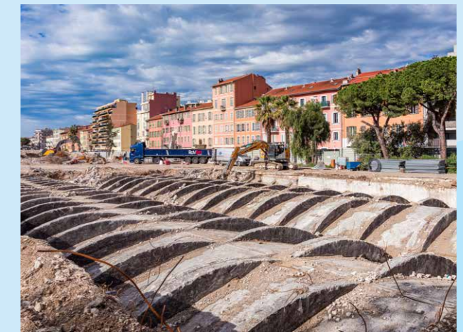
Travaux d'étanchéification des voûtes du Paillon (secteur De Lattre de Tassigny).
