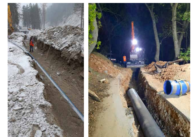
Saint-Martin-Vésubie - Route du Boréon - Renouvellement du réseau
