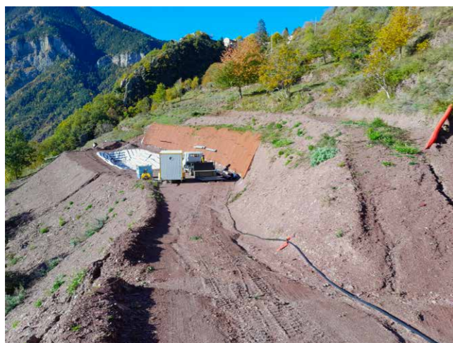
Roure – Construction de la station d'épuration des eaux usées
